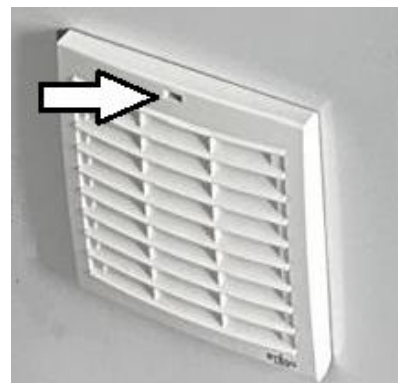
Abbildung 5.1. Gitter mit Lüfterfilter. Der Pfeil zeigt den Schlitz an.
